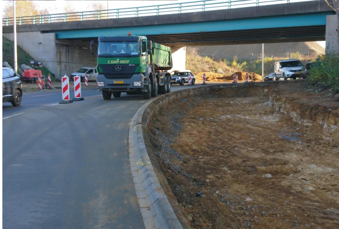
Les travaux, qui sont réalisés en phases, nécessitent la fermeture temporaire de différentes parties de la chaussées, avec une réduction massive de la capacité!
